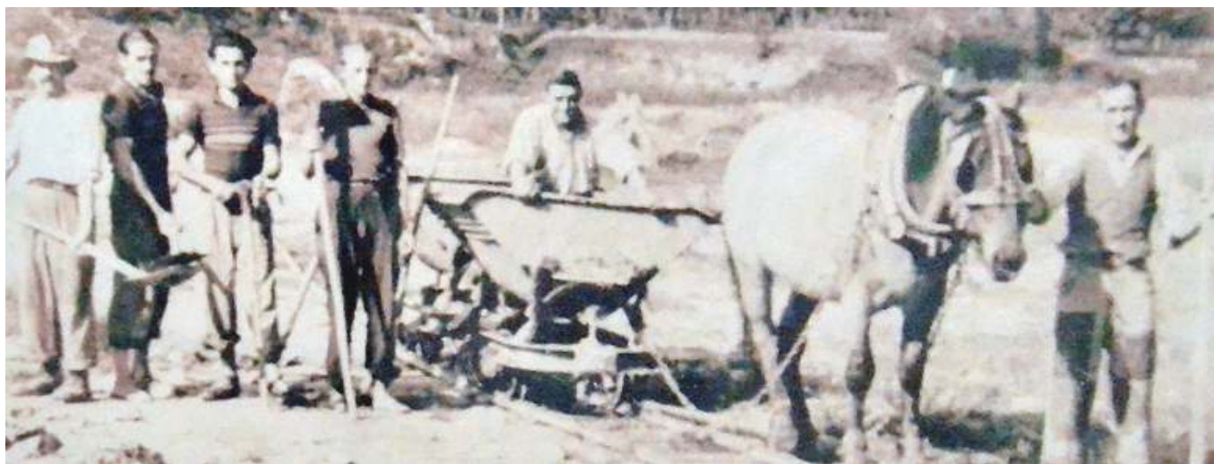
Il lavoro. Il duro lavoro nelle fornaci: qui l'approvvigionamento e il trasporto dell'argilla a Corte Franca con un vagonetto trainato da un cavallo
